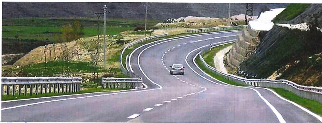
Fig. 21 -Rruga Kombëtare Interurbane Kombetare Levan – Tepelene - Gjirokaster
