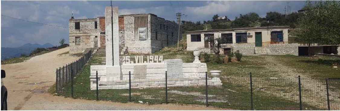
Fig. 42 -Pamje e gjendjes ekzistues te qendres se fshatit Dukaj
