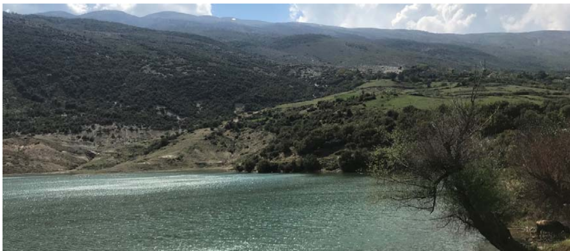
Fig. 38 - Pamje e rezervuarit te Turanit, me kapacitet per ujitjen e te gjitha territoreve bujqesore pergjate perroit te Turanit
